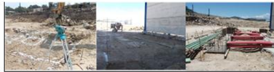
Obra civil y eléctrica para registros de transformadores.
