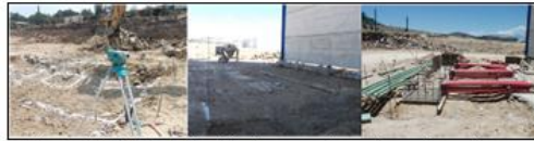
Ilustración 2: Obra civil y eléctrica para registros de transformadores.
